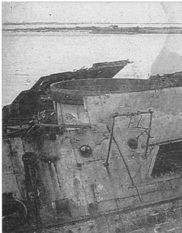
Рис. 71. "Цесаревич" на разборке. Барбет кормовой башни.
