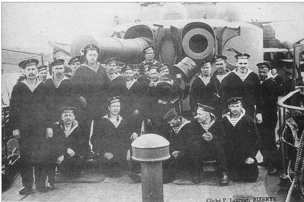
Рис. 72. Носовая башня. Хорошо видны створки, закрывающие орудийные амбразуры и серьги на крыше в передней части башни. Амбразура в колпаке командира башни закрыта заслонкой. На переднем плане съемный вентиляционный дефлектор. Обратите также внимание на леерные стойки. В средней части леер выполнен в виде прутка, а в верхней части в виде деревянных перил (См. также рис.73).
